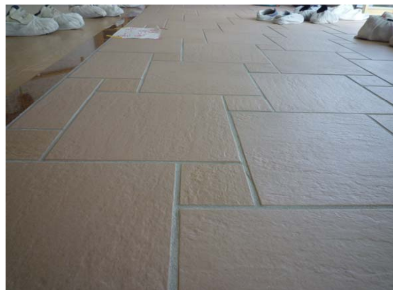
K棟玄関床タイル
