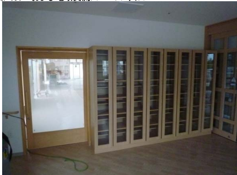
K棟 カフェおよび地域交流スペース 入口
