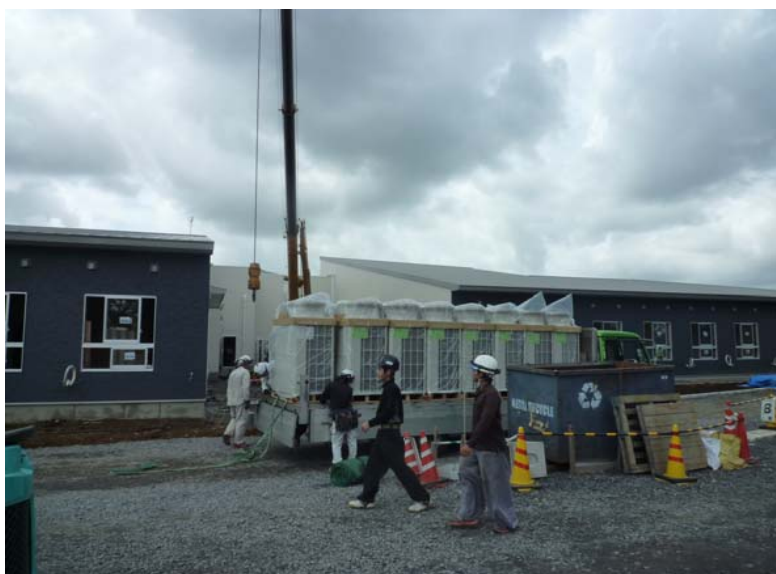
空調室外機 搬入
