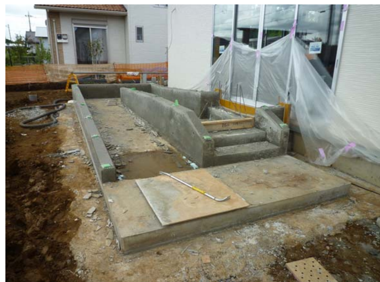
K棟 イベントスペース 階段とスロープ
