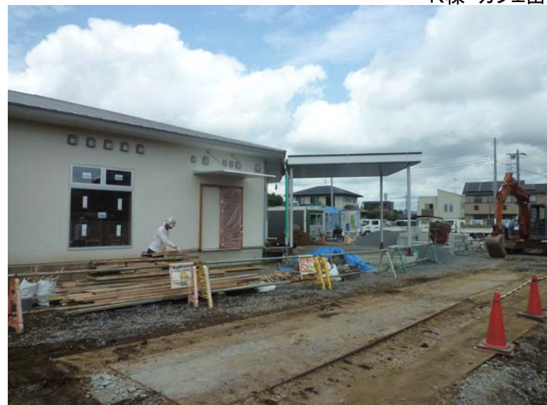
K棟 カフェ出入口
