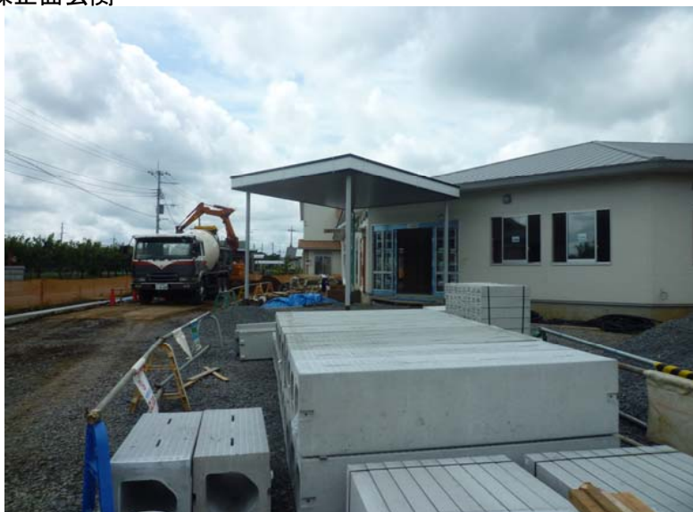
K棟正面玄関
