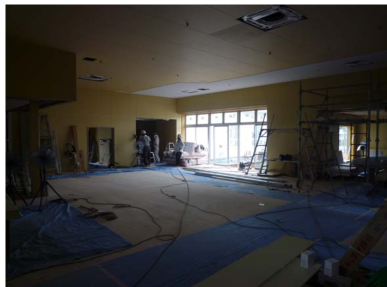
S棟 天井ボード貼り
