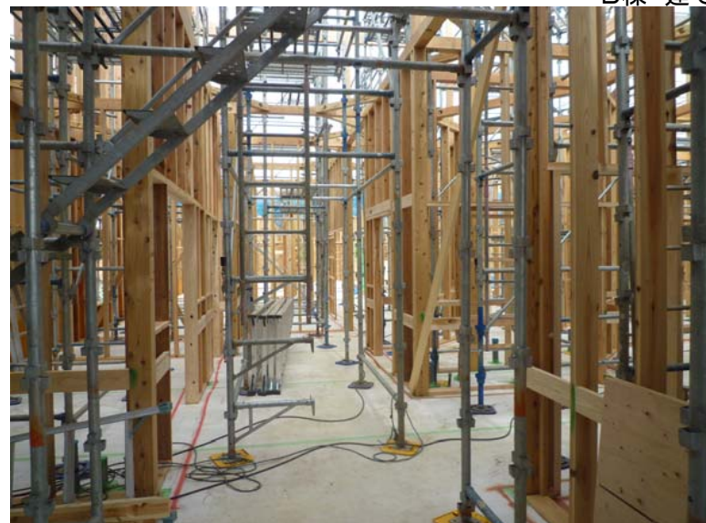
B棟 建て方
