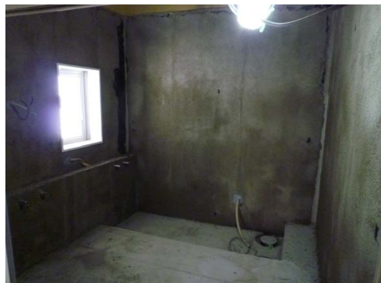
C棟 リフト浴室(タイル下地の施工後)
