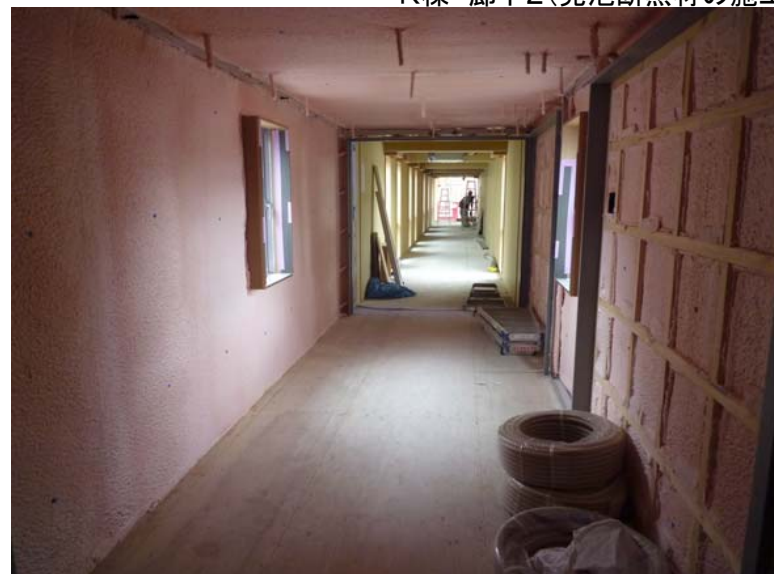
R棟 廊下2(発泡断熱材の施工後)
