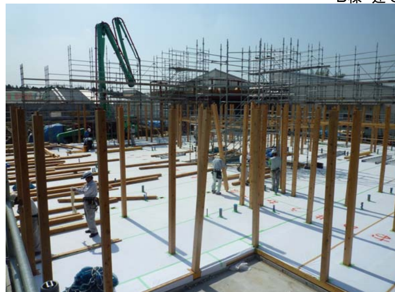
B棟 建て方
