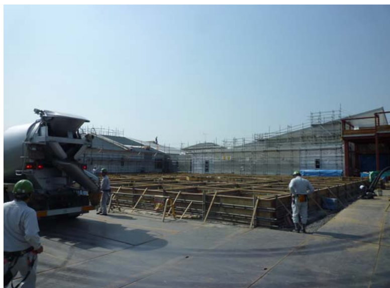
A棟 基礎立上り打設
