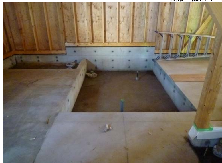
K棟一般浴室 浴槽
